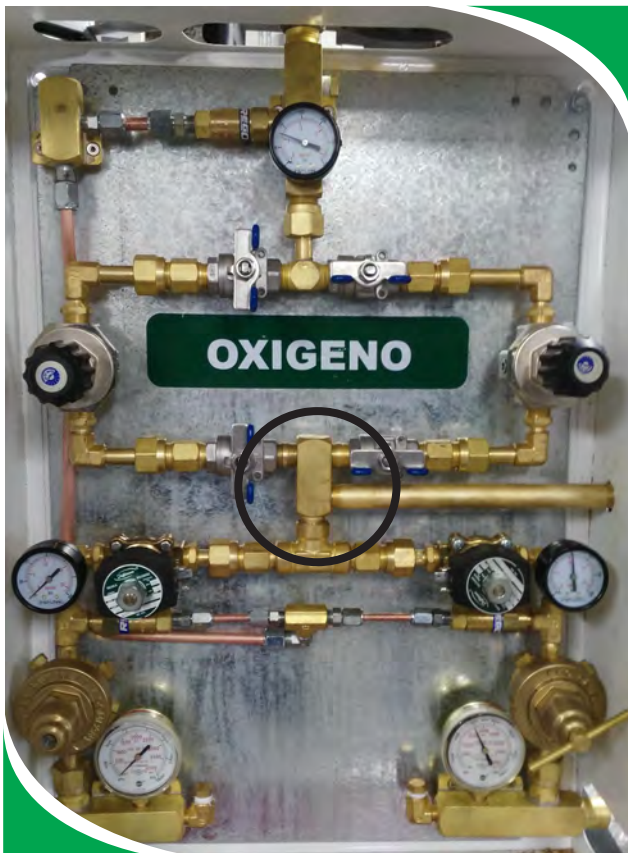
Manifold para Sistema Criogénico (con puerto de emergencia)
