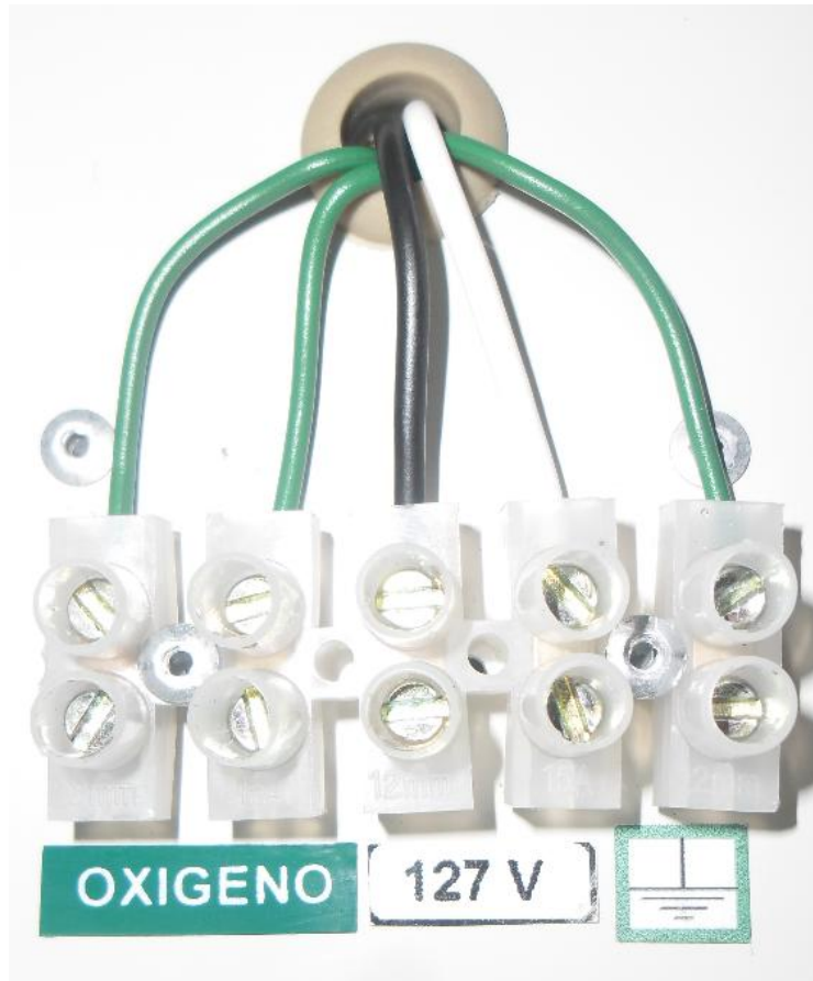
Fig. 1 Tablilla de conexión (Alarma de un gas).
