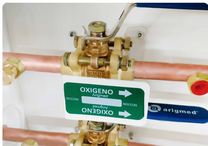
Válvulas para caja de seccionamiento
