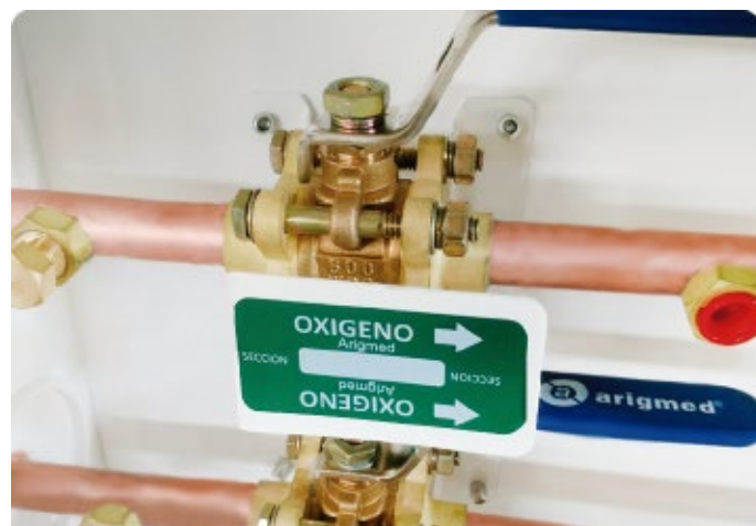
Válvulas de gases medicinais
